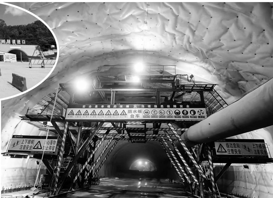
金钗岭隧道右洞施工现场。通讯员 徐向军 秦奎林 摄
