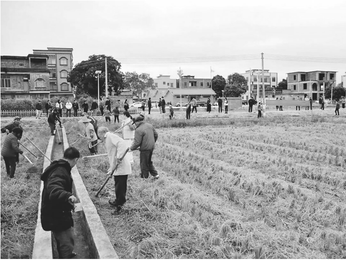
沙琅镇修建水利项目现场如火如荼。通讯员 吴祖武 摄
