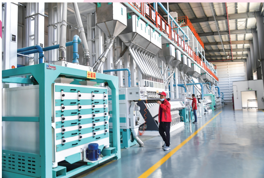
化州市广东粮之源粮油实业有限公司大米加工车间。
