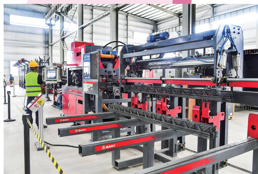
高州市高盛实业公司建筑工业智造项目。
