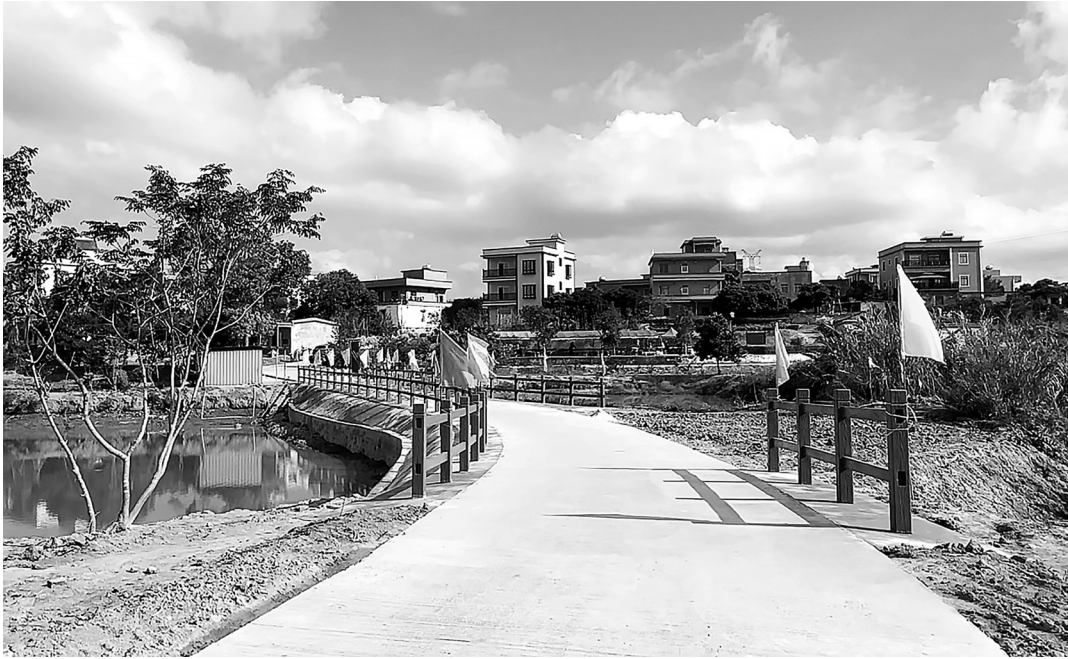
升级改造后的新兴路宽敞平整。
