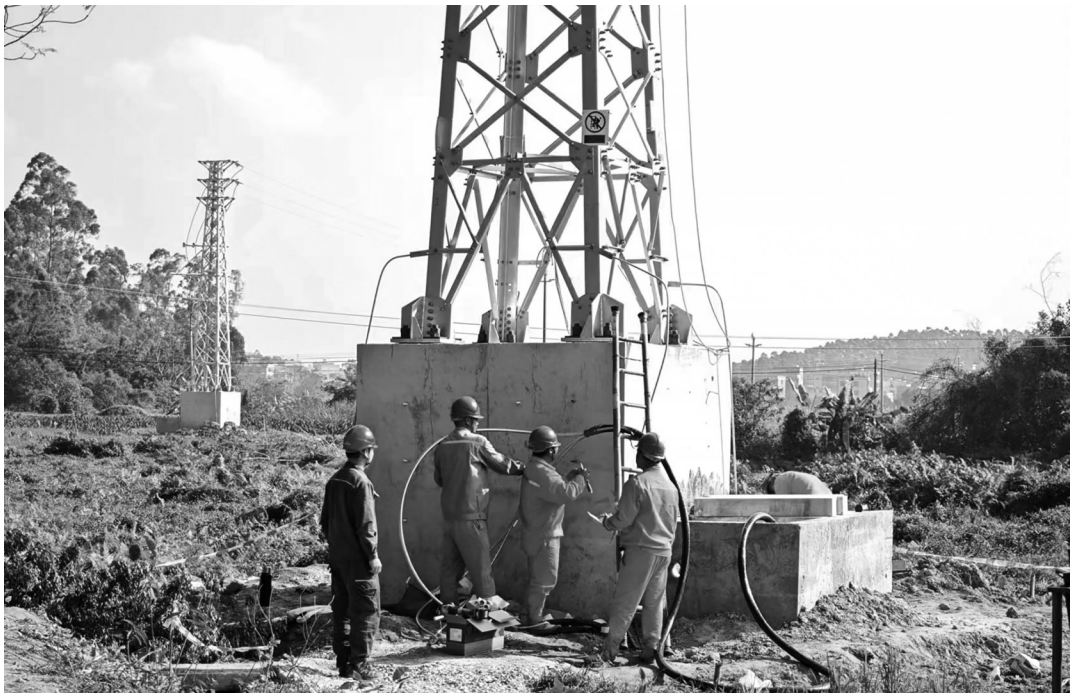
在化州市良光镇10千伏旺财线陡边村附近的电力施工现场,工作人员正在制作电缆头。 通讯员 颜诗华 摄
