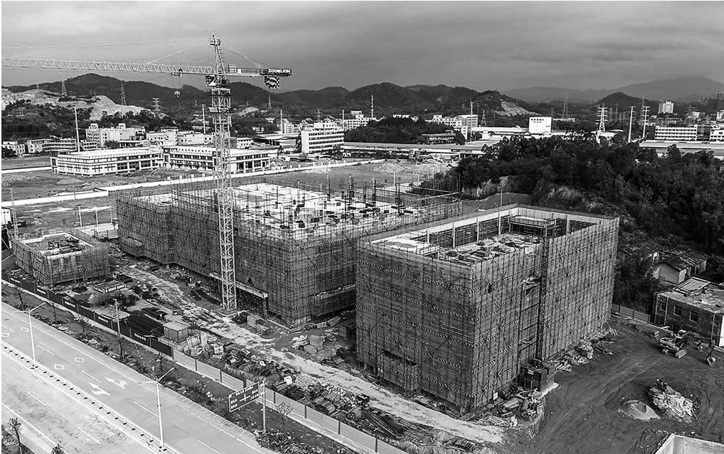
在建中的信宜佳都服装制衣有限公司。茂名日报社全媒体记者 甘杨松 摄
