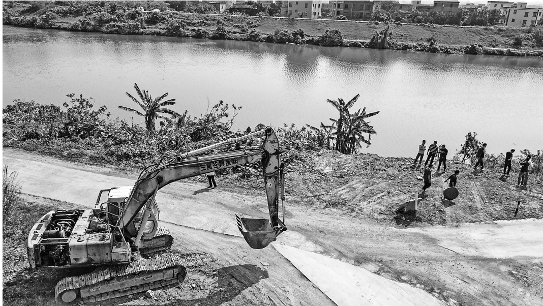
大王湾大桥施工现场。茂名日报社全媒体记者 黎雄 摄
