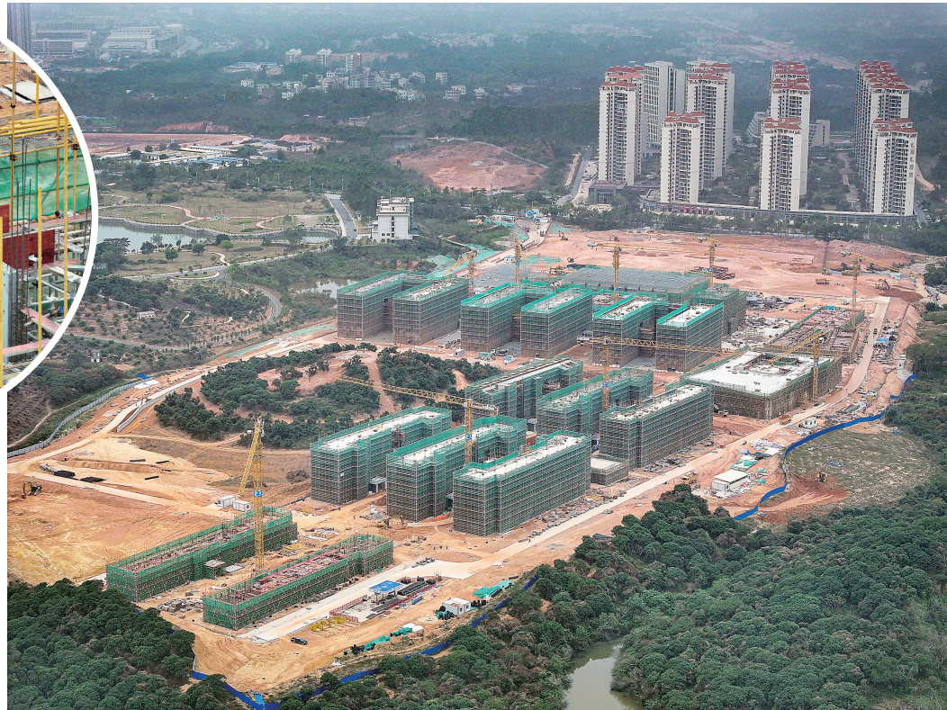
广东实验中学附属茂名学校高中部施工现场井然有序。茂名日报社全媒体记者 刘付思明 摄
