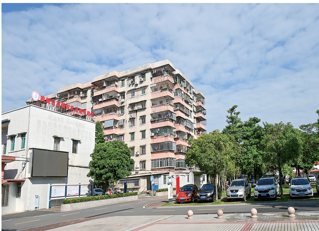
改造后的河西街道油城社区旧貌换新颜。本报记者 黄信涛 摄
