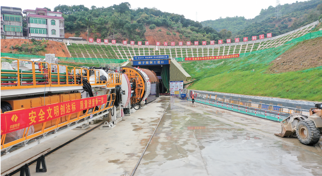
施工现场井然有序。
