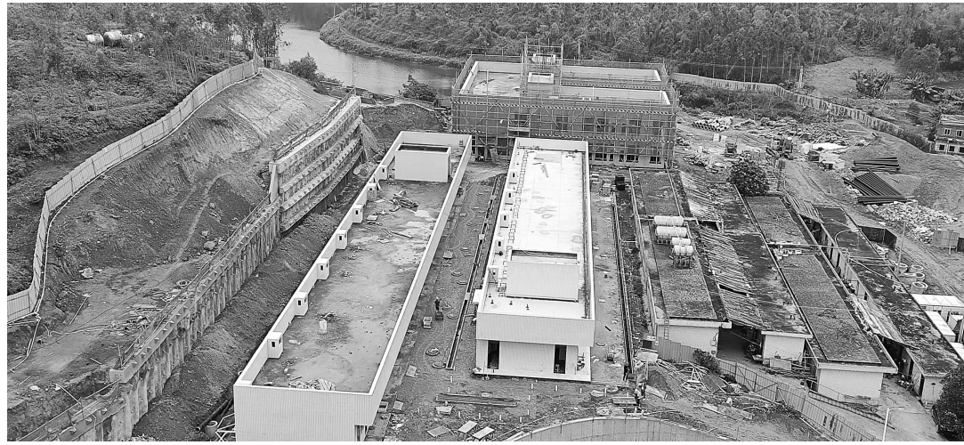
化州医疗领域重点项目建设现场。
