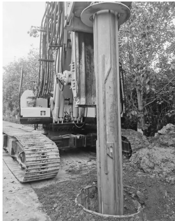
首桩开工点位置。
