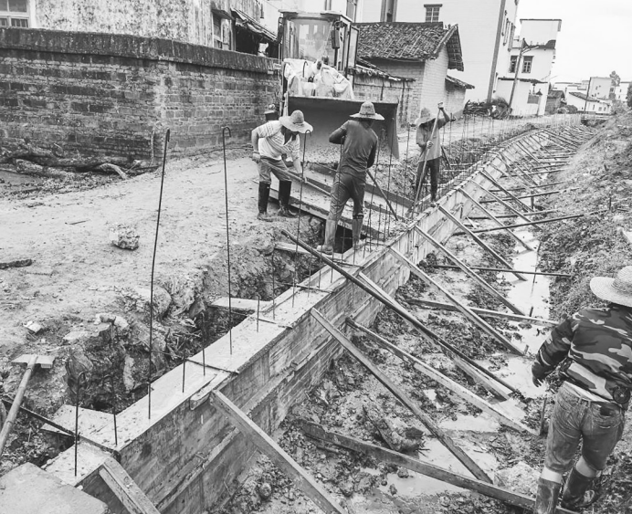
村民投工投劳建设村道。 通讯员 曾霞 摄
