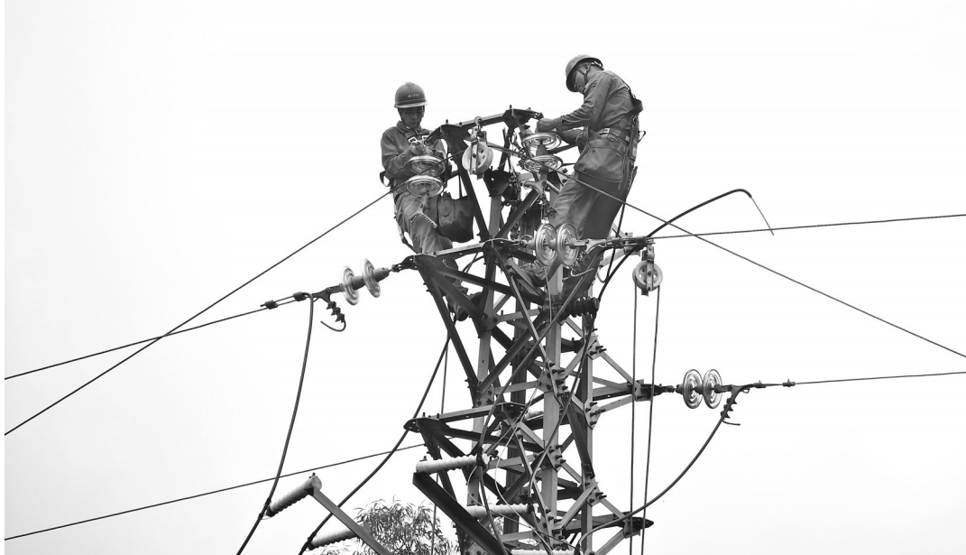
供电施工人员正在安装线路绝缘子。通讯员 颜诗华 摄
