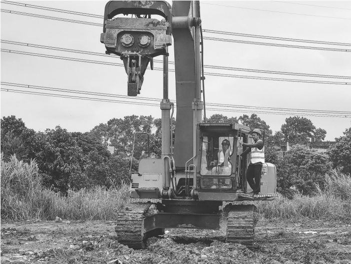
特种机械打桩机作业技能培训现场。
