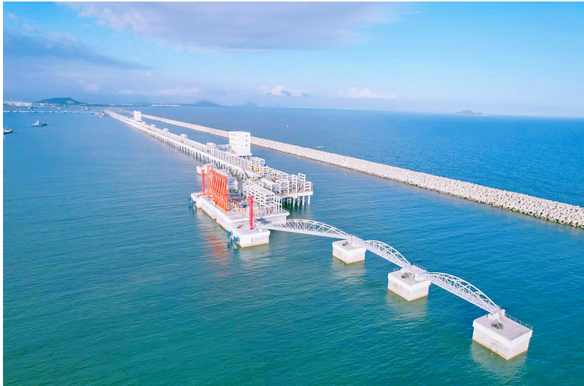
茂名港博贺新港区东区油品码头全景。通讯员 钟霞宇 摄
