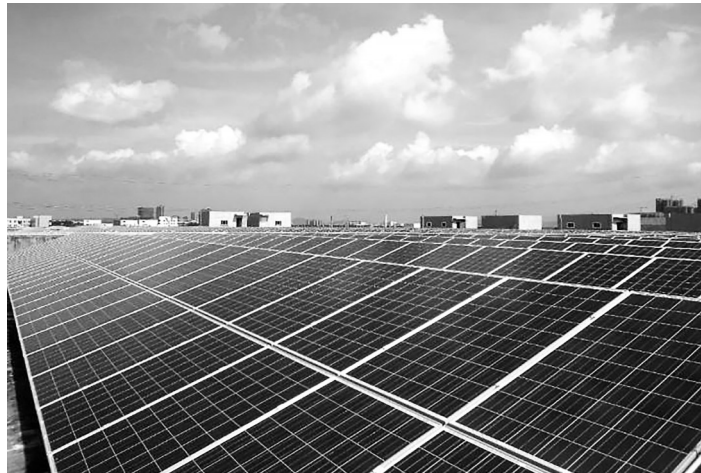
化州市国有屋顶光伏项目正在有序推进。
