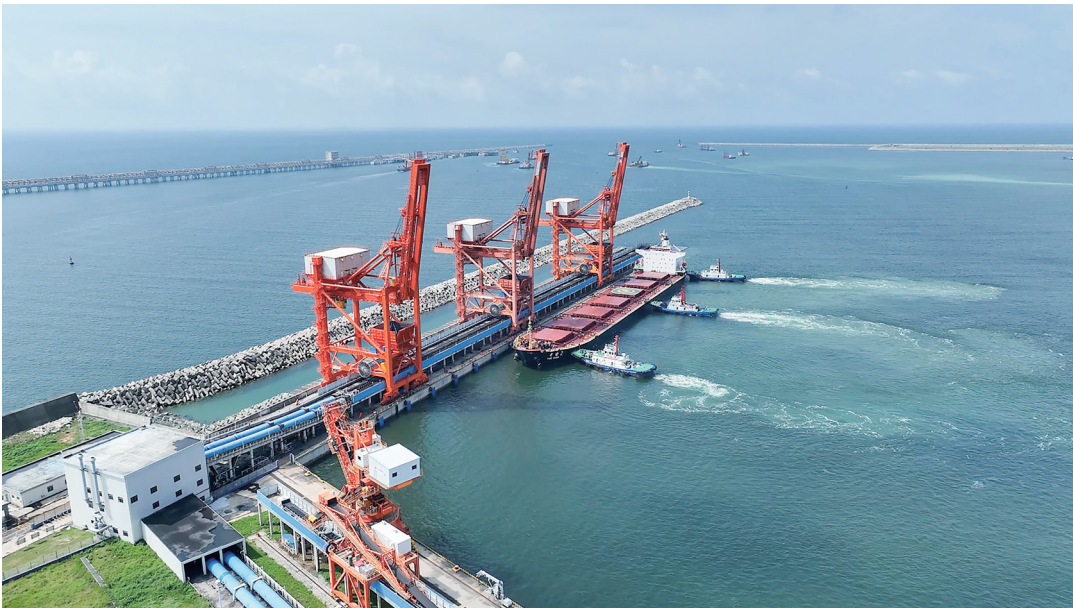
运载电煤6.9万吨的“粤电2”轮进港靠泊粤电十万吨卸煤码头。通讯员 黎国锋 摄
