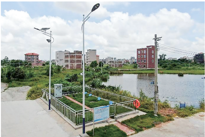
上车头村污水处理站点。
