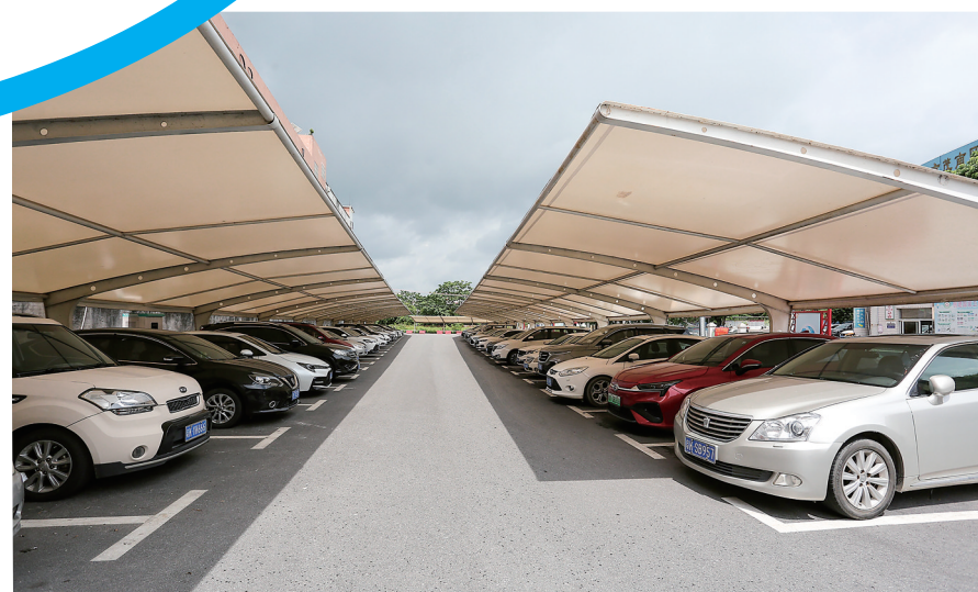
公馆镇高规格建设了3个大型公共停车场,满足群众停车需求。
