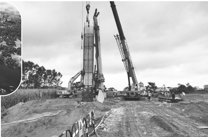
化州市南安大桥新建工程施工现场。
