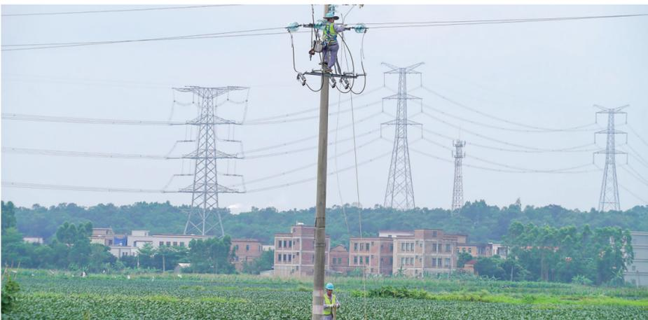
茂南供电局金塘供电所组织施工单位人员更换10千伏桂山线田头屋支线。郝俊英 摄
