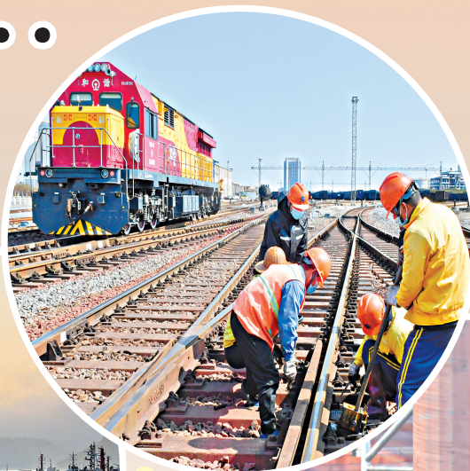
▲工人对码头专用铁路进行维护。
