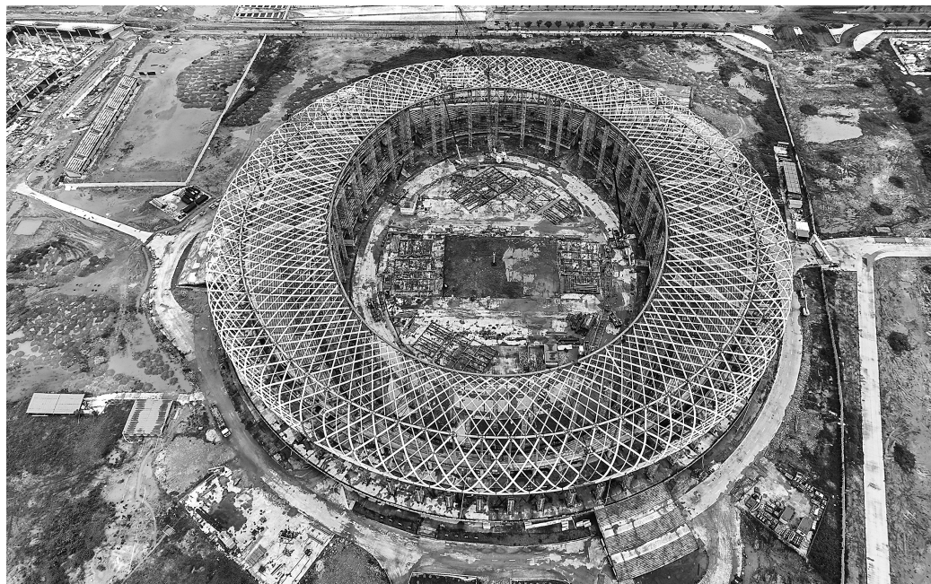
钢屋盖封顶施工现场。通讯员 李峰 摄
