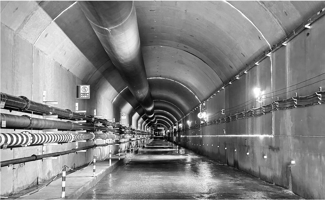
贵子支洞项目现场。
