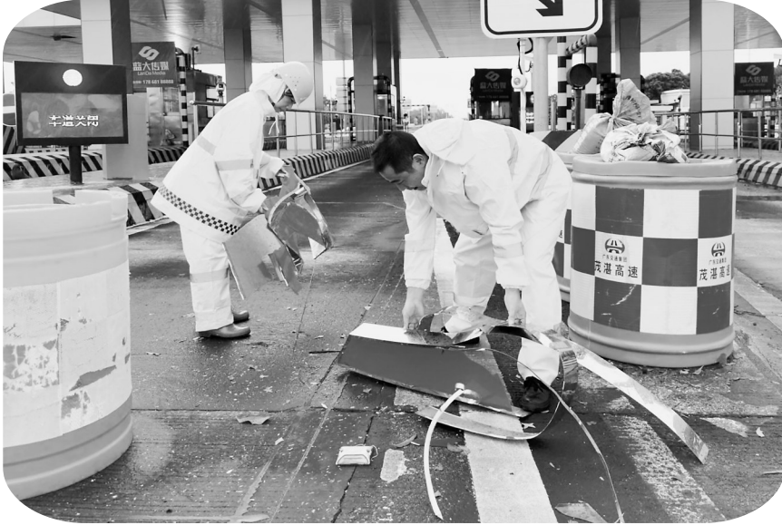
清理障碍物,加固受损交安设施。
