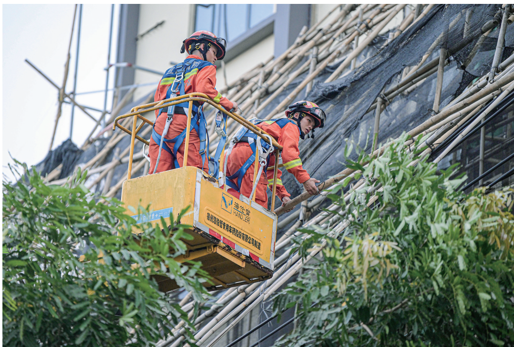
9月8日,在海南省澄迈县街头,澄迈县消防救援大队工作人员拆除一处被台风破坏的房屋脚手架。近日,受超强台风“摩羯”影响,海南省澄迈县发生灾情。澄迈县消防救援人员在当地积极开展清障、供水、救援等灾后修复工作,保障经济社会运行和群众生活恢复。
