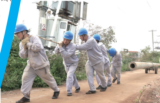
南方电网广东茂名供电局支援湛江徐闻队想方设法把电杆运到车辆到达不了的地方。梁宇宏 摄
