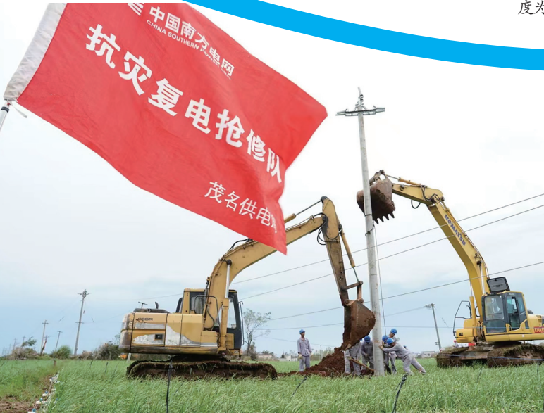
支援湛江徐闻西连镇抢修复电队正在合力立下电杆。梁宇宏 摄
