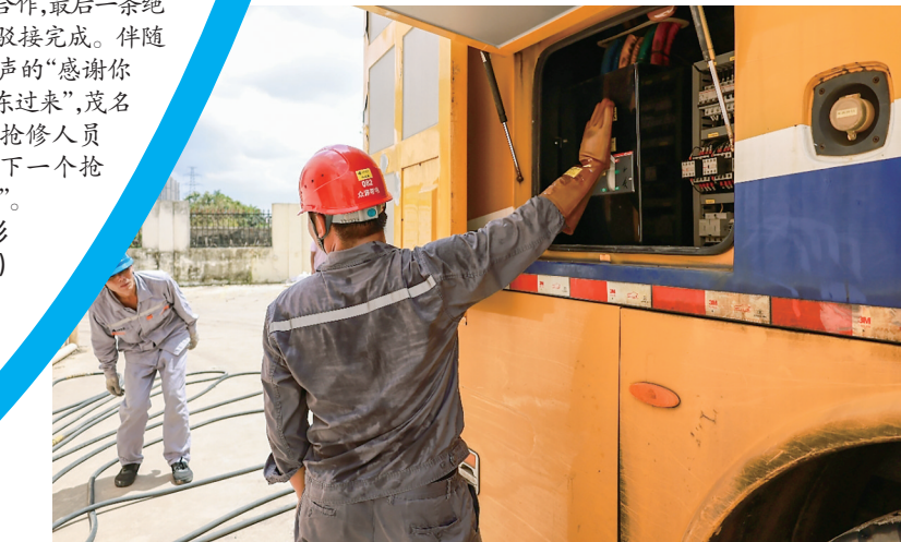
紧急驰援水泵站,解决道路积水问题。黄琦之 摄
