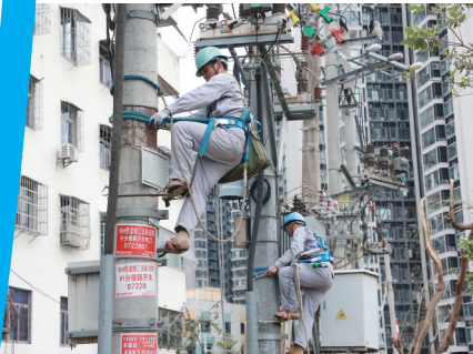
南方电网广东茂名供电局抢修队正在对10千伏侨龙线受损的导线和绝缘子、开关刀闸等设备进行更换。陈美影 摄
