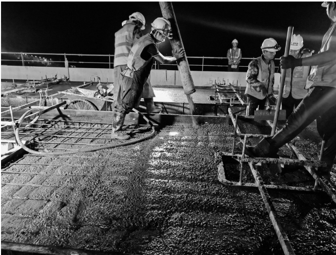
袂花江特大桥进行无砟轨道底座板混凝土浇筑施工。
