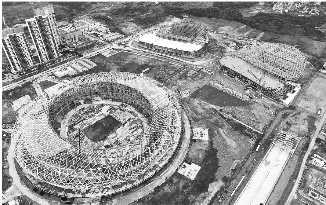
奥体中心建设初具雏形。
