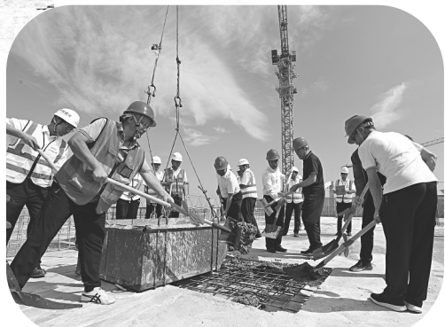
▶广湛铁路茂名南站站房主体结构浇筑最后一方混凝土。
