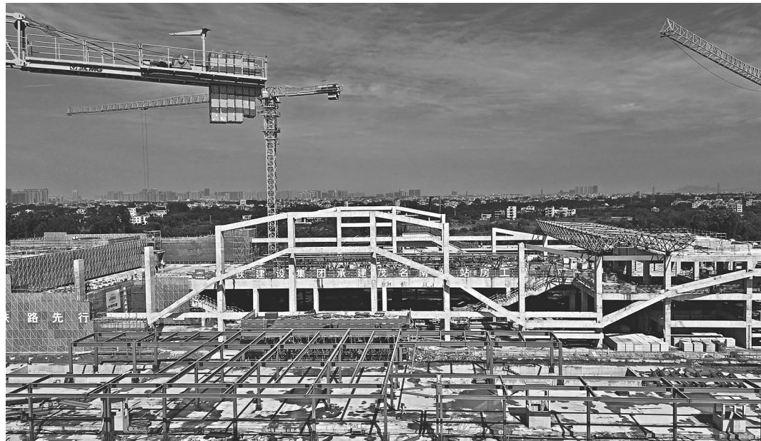
广湛铁路茂名南站站房主体结构封顶。茂名日报社全媒体记者 岑稳 摄
