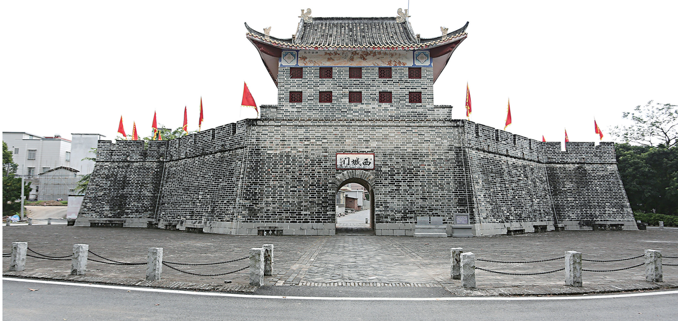
外观雄伟的长坡镇旧城村西门。
