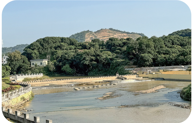
建设中的楼梯状灯光叠水区。
