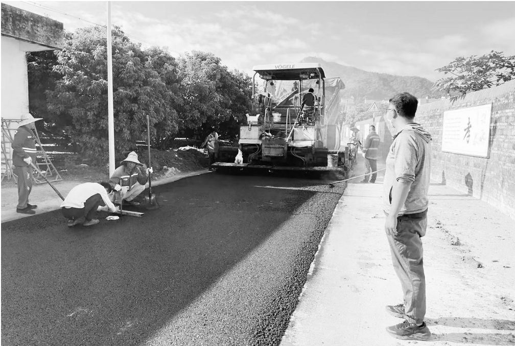
大翰村有田大道施工现场。通讯员 张铨映 摄
