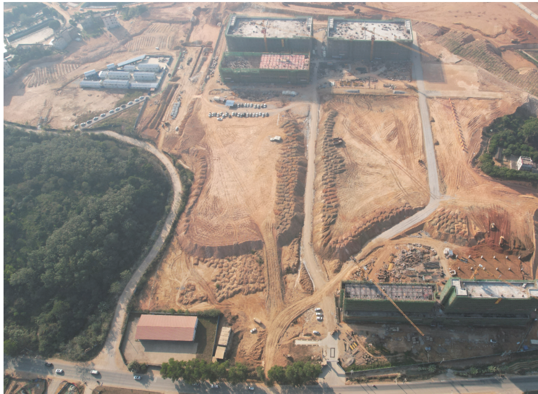
乐天高科技(高州)产业园项目建设现场。
