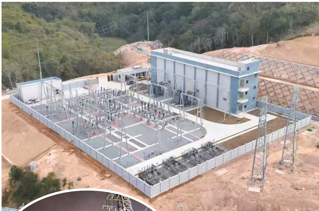
▲110千伏曹江变电站如期竣工投产。
