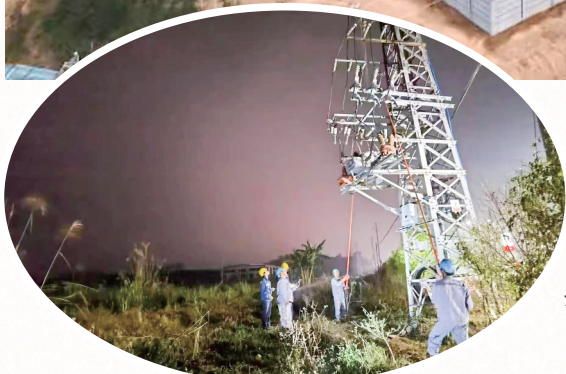
◀为确保线路顺利投产,供电人员开展单相对地、相间相序核对作业。 通讯员 王茂亮 摄
