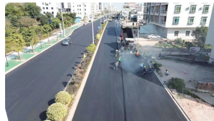
县道X729线(梅石路)博龙至勒垌段 改建工程沥青摊铺施工现场。
