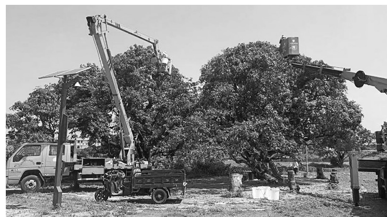
工人对古荔枝树进行修整。
