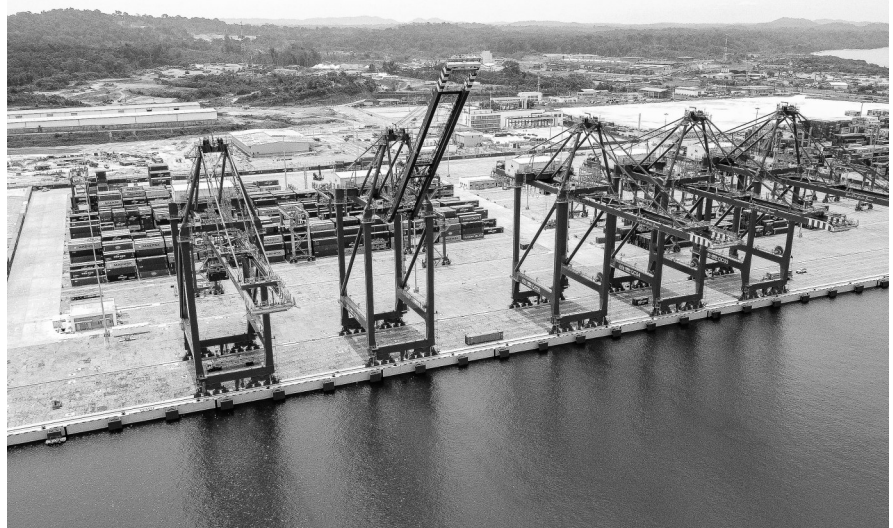
这是2月21日在喀麦隆南部大区的克里比拍摄的喀麦隆克里比深水港(无人机照片)。
