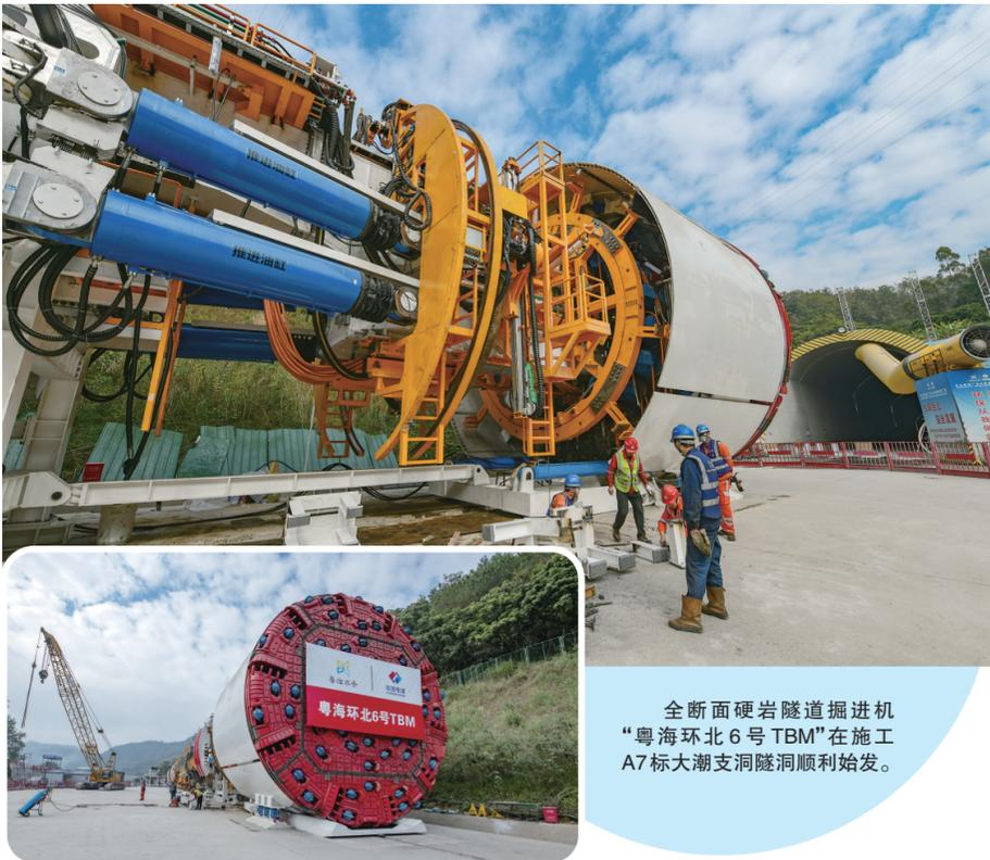
全断面硬岩隧道掘进机“粤海环北6号TBM”在施工A7标大潮支洞隧洞顺利始发。
