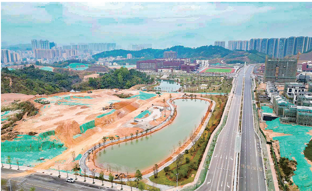
湖塘沟渠排洪排涝改造项目稳步推进。
