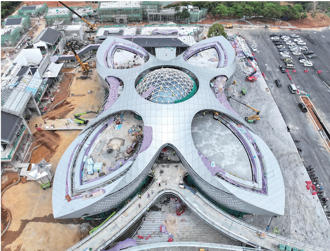
即将交付使用的柏桥服务区
