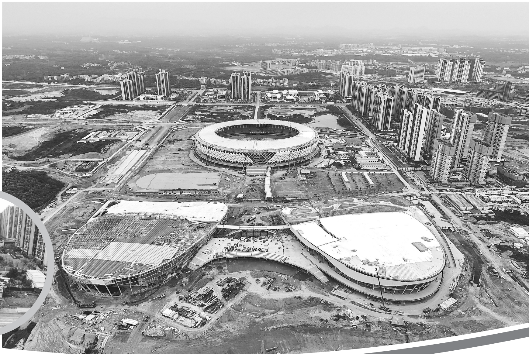
奥体中心主场馆周边道路加紧建设。
