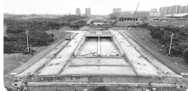
奥体大道一期建设现场。
