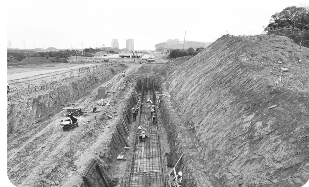
奥体大道二期工人在建筑地下管廊。
