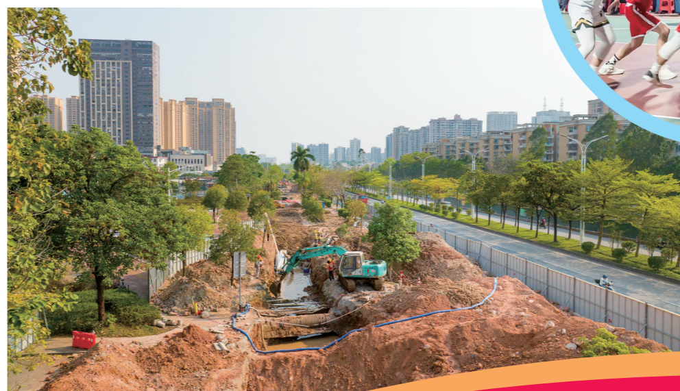
茂名大道快速化改造现场。吴佰洋 摄
