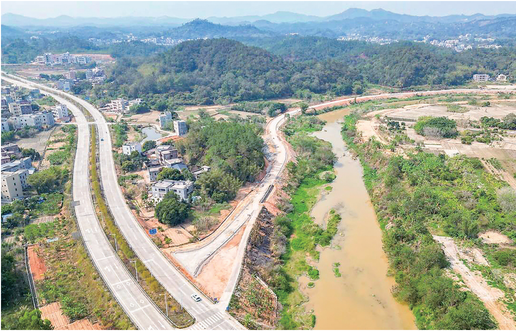
西江大道施工有序推进。
