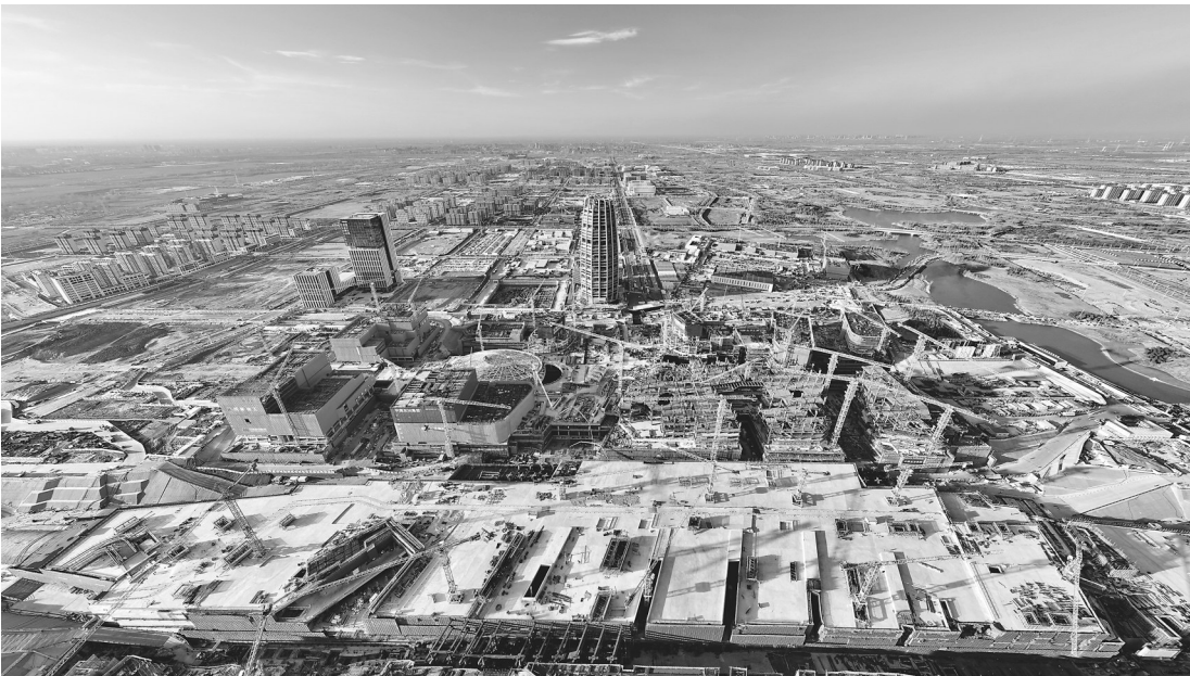
雄安新区启动区内塔吊林立的建设场景(2025年3月19日摄，无人机照片)。 新华社记者 牟宇 摄
