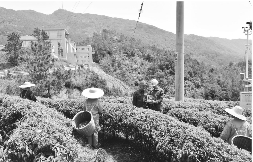
信宜供电局运维人员对10千伏茶园专线开展专项巡视。通讯员 叶茂 摄
