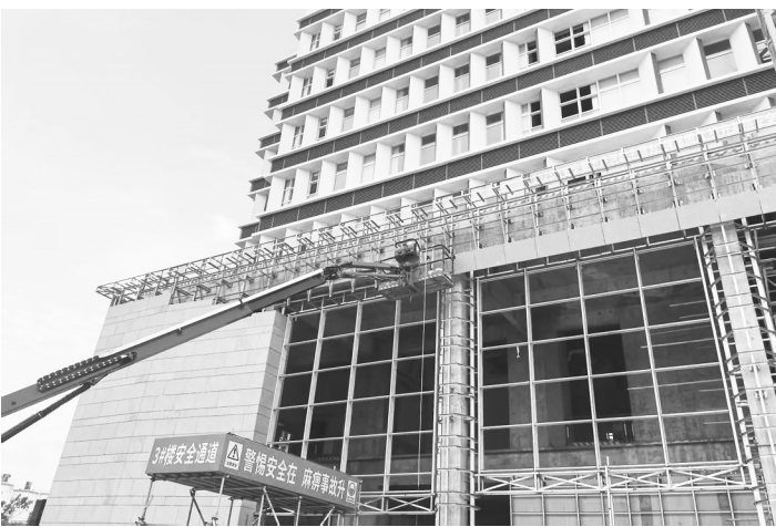
电白区公共卫生建设项目石材幕墙安装。
