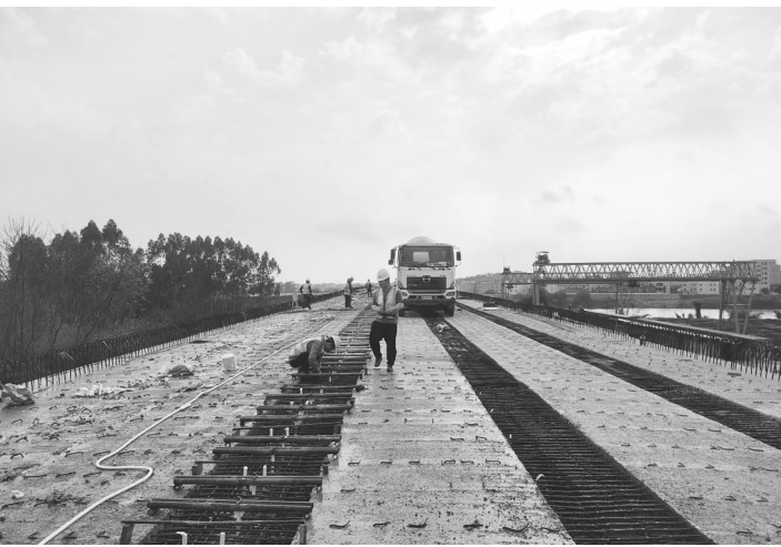
化州市南安大桥新建工程项目建设施工中。
