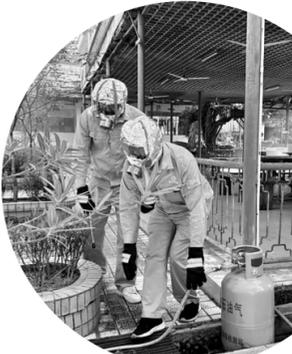
▲燃气公司专业技术人员对管道泄漏点进行堵漏作业。
